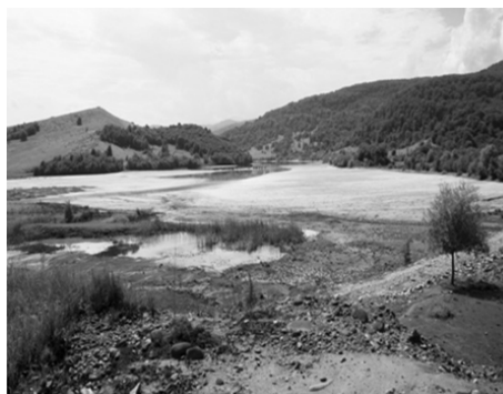
Рис. 19.4. Техногенное месторождение комплексных руд, нижняя чаша отстойника хвостохранилища Урупского ГОКа (Источник: фото автора – А. А. Бурцева)
